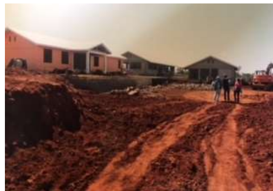
L'édifice de l'école Flame Tree Vocational School au Karatu District, en Tanzanie
